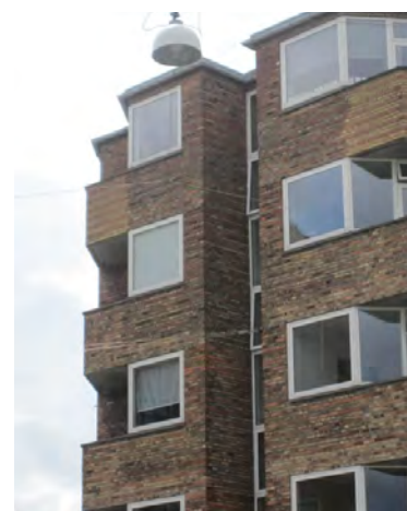
På Finsensvej 61 er altanværnene en integreret del af murværket.
