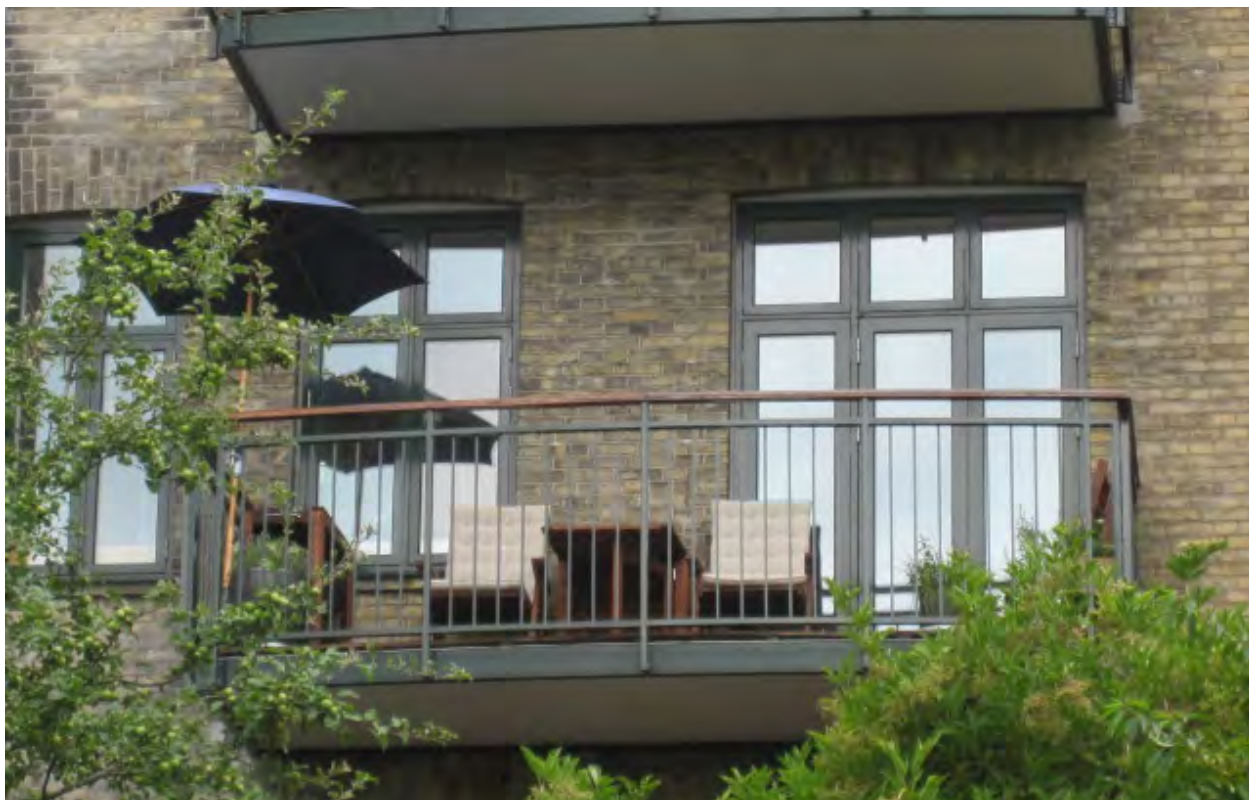
Dørpartiernes tværpost flugter smukt med vinduernes tværpost. Altankant og værn har fået samme farve som vinduer og dør. Hostrupsvej 8.
