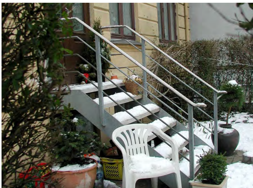
Mathildevej 18 med ny havedør og nedgang til have. Ståltrappen muliggør, at kældervindue beholdes intakt.
