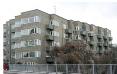
Bygningskroppen og altanerne spiller sammen. Øverst indeliggende altaner på Aksel Mølles Have 2-4. Nederst påhængte altaner på C. F. Richs Vej 89-93.
