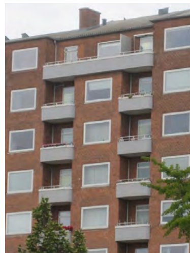
Bygningskroppen og altanerne spiller sammen. Øverst indeliggende altaner på Aksel Mølles Have 2-4. Nederst påhængte altaner på C. F. Richs Vej 89-93.
